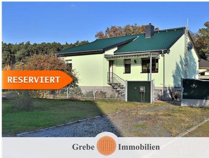
Blick von der Straße
